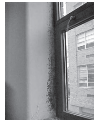
รูปที่ 6 ราเกิดขึ้นที่ขอบกระจกขึ้นจาก การควบแน่นของไอน้ำ
