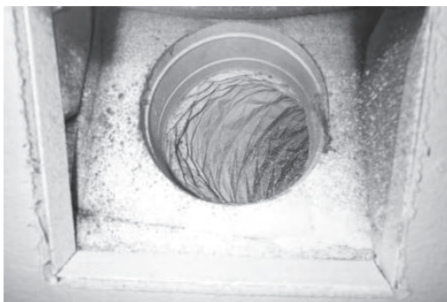
รูปที่ 9 ราที่ปลายท่อก่อนจ่ายสู่หน้ากักจ่ายลม
